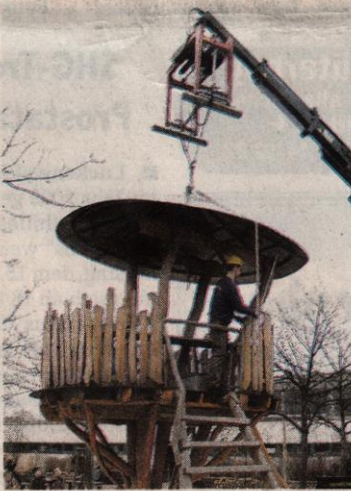
Das Dach des Baumhauses konnte erst im Dezember aufgesetzt werden.
